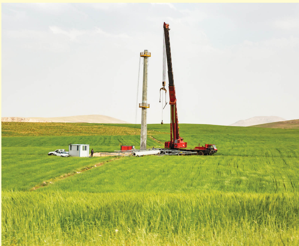
ادامه عملیات احداث پروژه "خط انتقال ۴۰۰ کیلوولت باندل سه سیمه میاندوآب - بوکان به همت همکاران متخصص و تلاشگر شرکت پارس‌ساختار
