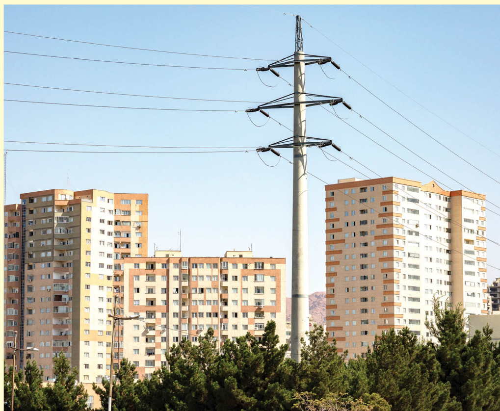
خط ۱۳۲ کیلوولت در خیابان توانیر کلانشهر تبریز به عنوان رینگ شرقی تبریز با استفاده از دکل‌های تک پایه خود ایستای بتنی پارس ساختار
